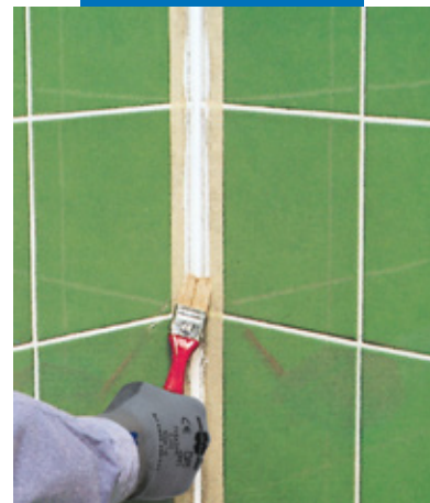
Згладжування шва за допомогою мильної води і маленького пензля
